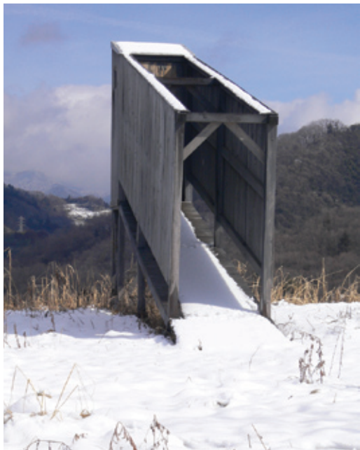
《絵画のための見晴らし小屋》 332.5×95.5×600cm(窓8) コンクリート基礎、木材、塗料、ガルバリウム鋼板
